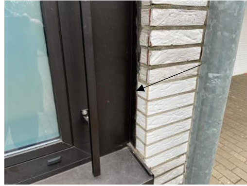
Abb. 11: Probe 08, , Fugenmasse am Anschluss Fenster/Fliese inkl. PU-Schaum: PCB-haltig
